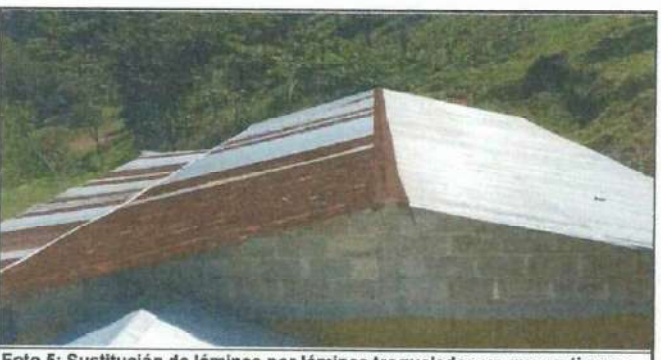
Foto 5: Sustitución de láminas por láminas troqueladas ya que en tiempo de invierno cae gotas de agua dentro del salon de clases de manera que el techado del Instituto sea seguro.
